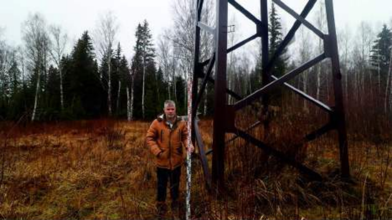
Илл. 48. Обследование территории земельных участков проектируемого объекта «Реконструкция ВЛ 220 кВ Нижегородская ГЭС - Вязники» 2 этап. Северо-восточная оконечность проектируемой ВЛ. Опора №17. Вид с юго-востока.
