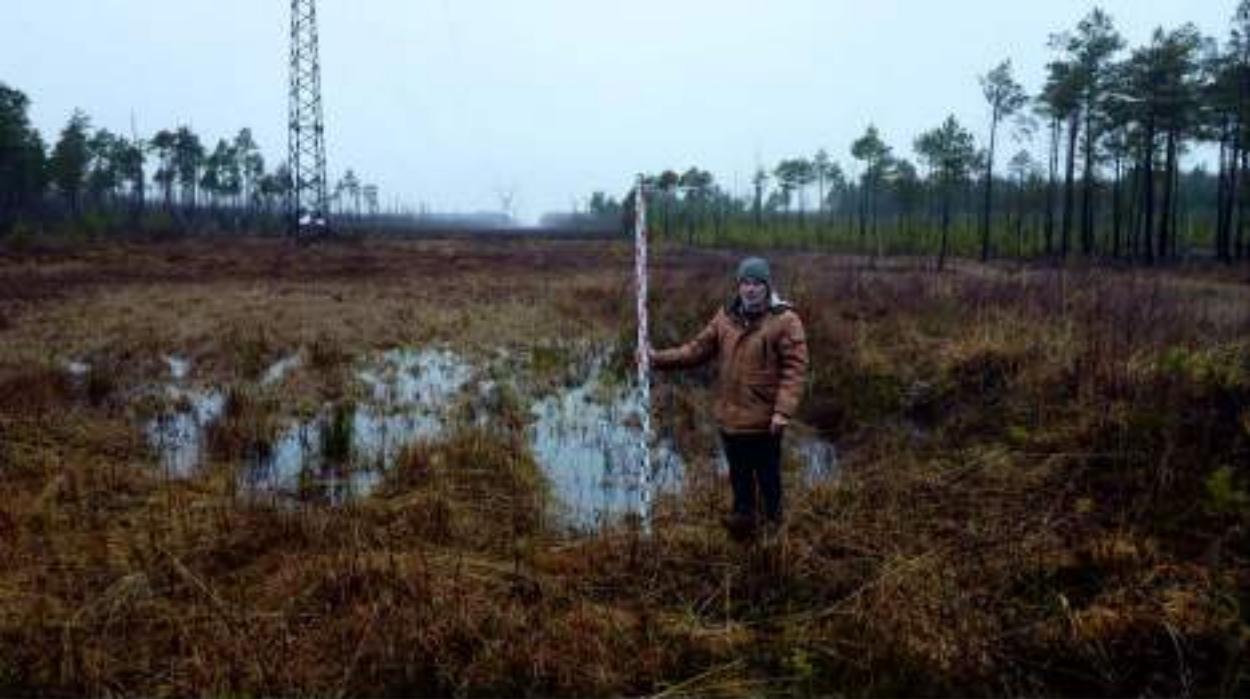
Илл. 122. Обследование территории земельных участков проектируемого объекта «Реконструкция ВЛ 220 кВ Нижегородская ГЭС - Вязники» 2 этап. Участок трассы к югу юго-востоку от д. Андреево. Вид с запада.
