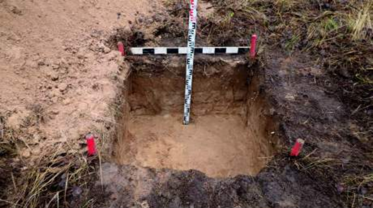
Илл. 20. Обследование территории земельных участков проектируемого объекта «Реконструкция ВЛ 220 кВ Нижегородская ГЭС - Вязники» 2 этап. Вид с юга на северный профиль и донную часть шурфа 1.
