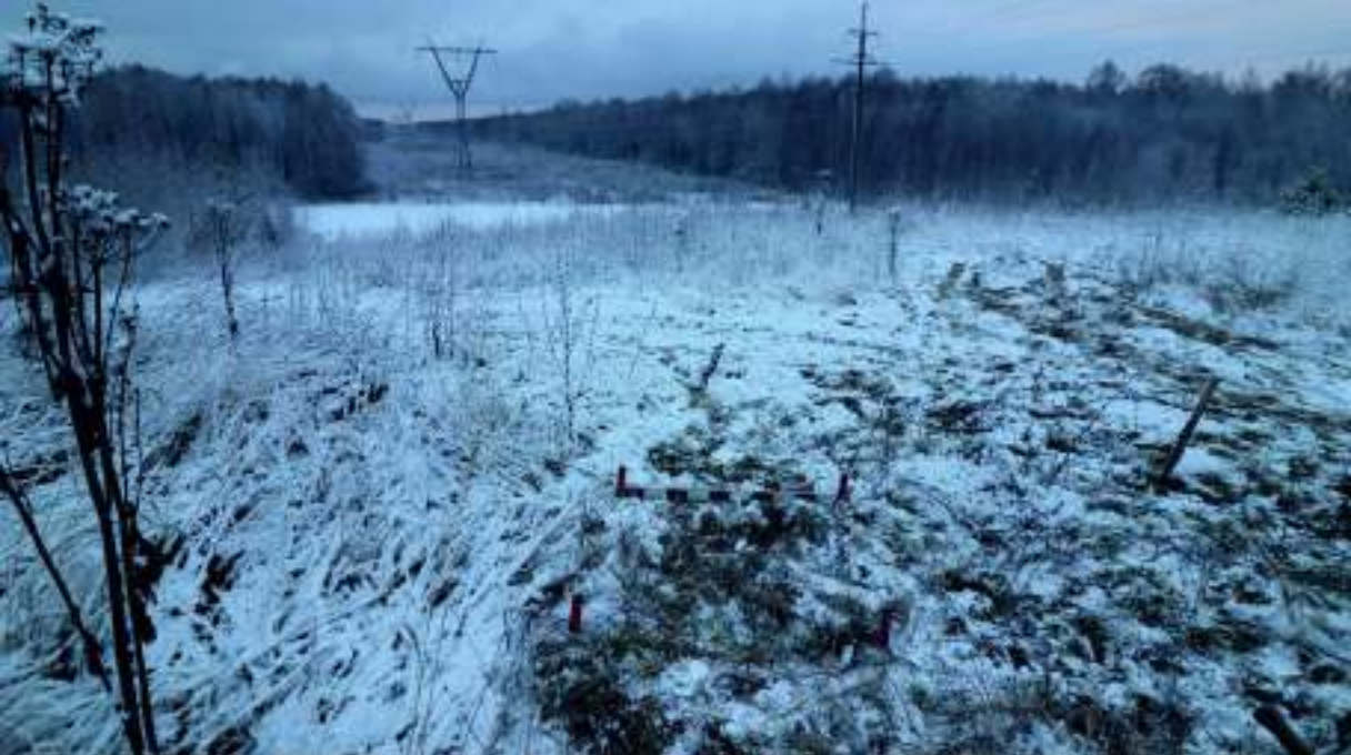
Илл. 72. Обследование территории земельных участков проектируемого объекта «Реконструкция ВЛ 220 кВ Нижегородская ГЭС - Вязники» 2 этап. Разбивка шурфа 11. Вид с запада.
