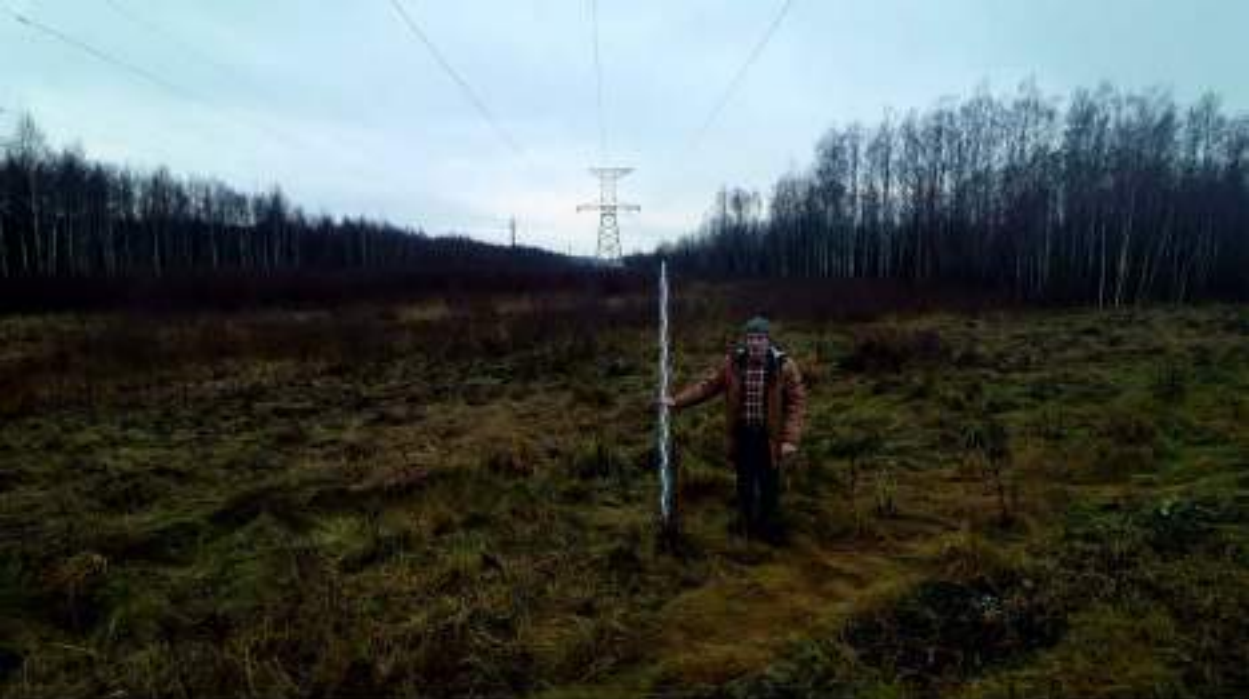
Илл. 70. Обследование территории земельных участков проектируемого объекта «Реконструкция ВЛ 220 кВ Нижегородская ГЭС - Вязники» 2 этап. Участок проектируемой трассы между автодорогой 22Р-0152 и д. Урково. Вид с востока северо-востока.
