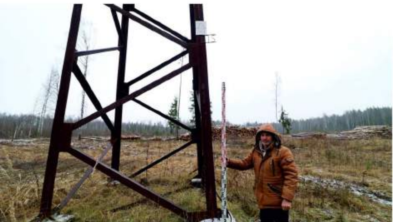
Илл. 137. Обследование территории земельных участков проектируемого объекта «Реконструкция ВЛ 220 кВ Нижегородская ГЭС - Вязники» 2 этап. Западная оконечность проектируемой ВЛ. Опора № 75. Вид с юга.
