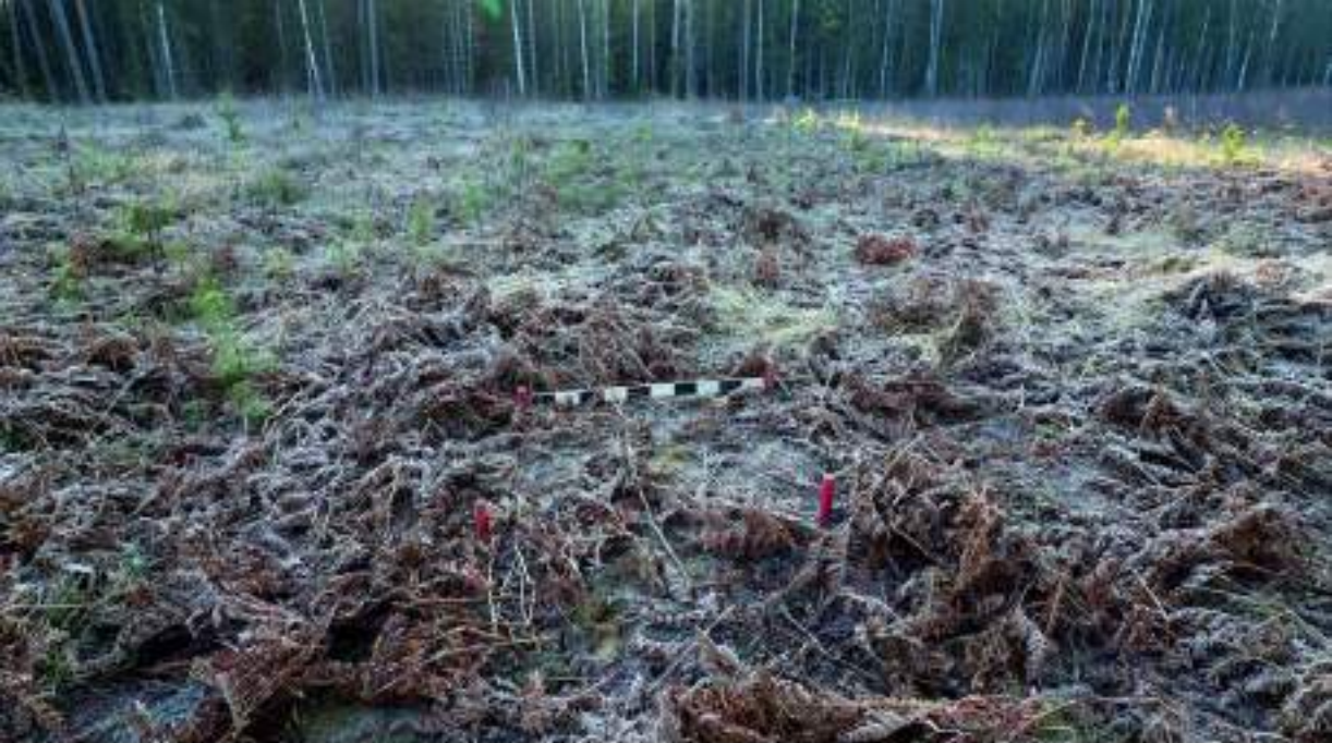
Илл. 110. Обследование территории земельных участков проектируемого объекта «Реконструкция ВЛ 220 кВ Нижегородская ГЭС - Вязники» 2 этап. Разбивка шурфа 19. Вид с севера.
