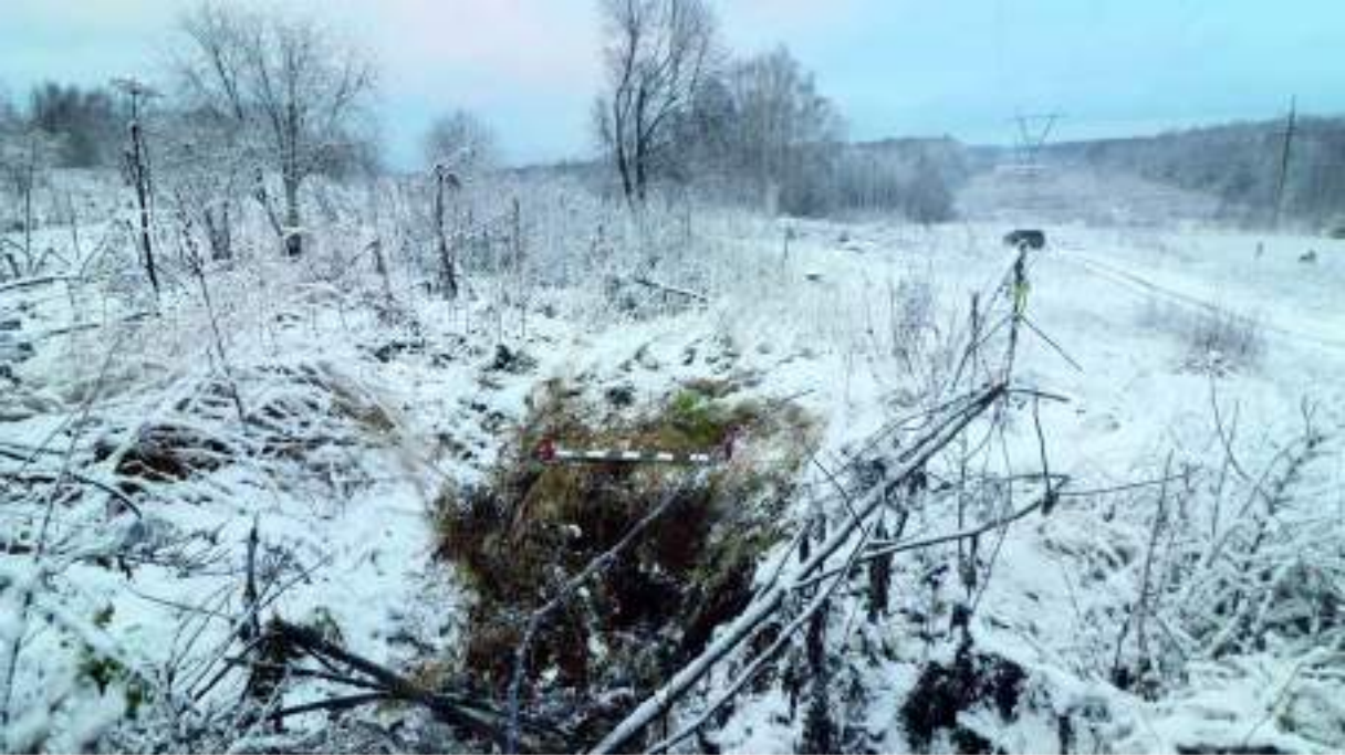
Илл. 76. Обследование территории земельных участков проектируемого объекта «Реконструкция ВЛ 220 кВ Нижегородская ГЭС - Вязники» 2 этап. Разбивка шурфа-врезки 12. Вид с запада.
